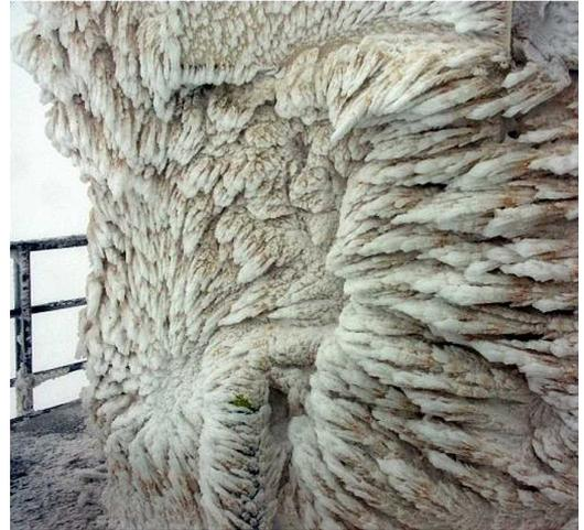
Abb. 1.5: Auf den Messgeräten und allen Gebäudeteilen des Sphinx-Observatoriums kommt es regelmäßig zu starkem Reifansatz. Die Verfärbung im rechten Bild entstand durch Staub aus der Sahara.
